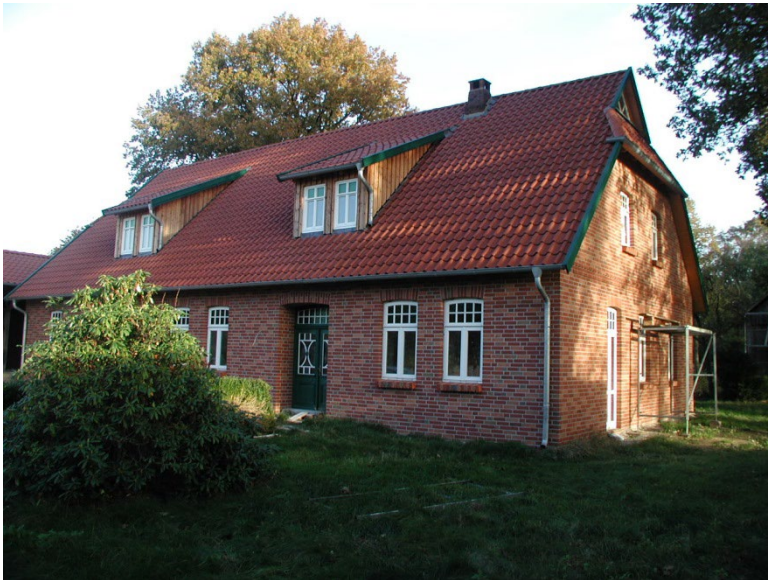
Dächer und Fassaden
