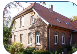
Ein gutes Beispiel: Ein umfassend saniertes Gebäude - Dach, Fenster, Steinverfugung
